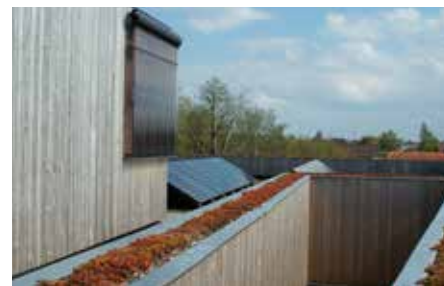
Zonnepanelen op het groendak en zonnecollectoren voor de warmwatervoorziening tegen de gevel.
