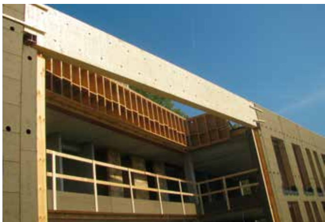
De hele terrasconstructie werd opgehangen aan deze lvl-balk.
