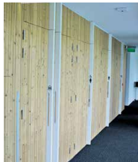
De beplanking met Plato®Hout werd doorgetrokken in het interieur.
