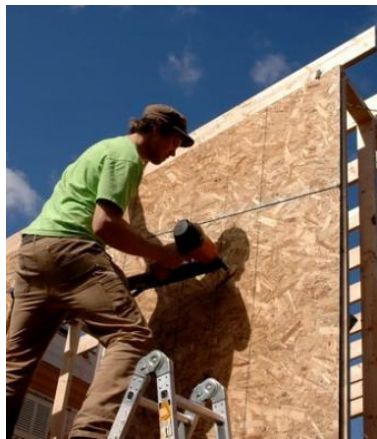
Verticaal, verdiepingshoog geplaatst OSB-beschieting
