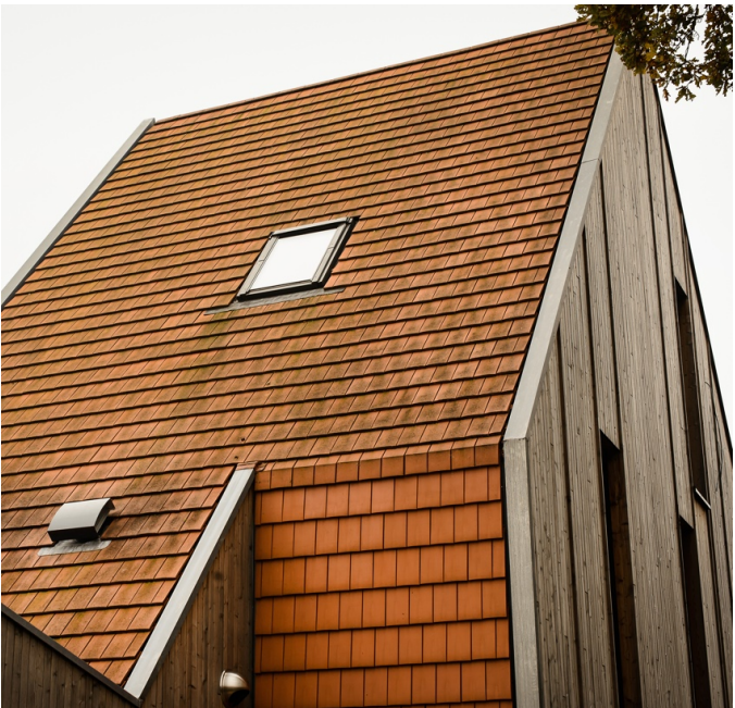
Om de lijn van het dak niet te doorbreken, werden er geen dakgoten geplaatst, maar werd voor een drainagesysteem gekozen.
